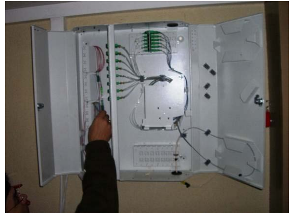
Instalación en el interior de un edificio adaptada con fibra óptica.
