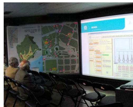
Centro control alcantarillado de Barcelona
