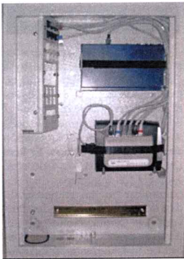
Figura 5. RTR sobredimensionado para albergar más servicios que los mínimos de ICT (Cortesía Dave Witter).
