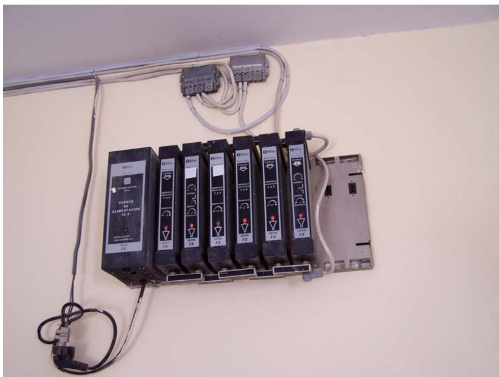
Equipo de cabecera actual, compuesto por 6 amplificadores para los canales 49, 52, 55, 59, 62 y 65.
