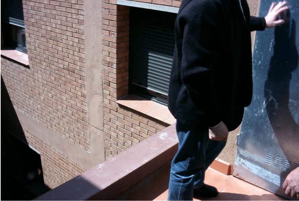
En este otro caso el RITS se encuentra situado en un espacio de difícil acceso y con una superficie de trabajo muy limitada, existe riesgo de caída a un patio de luces. No existe barandilla de seguridad, aunque una alternativa sería la existencia de anclajes para la colocación de una red de seguridad. Foto COETC.
