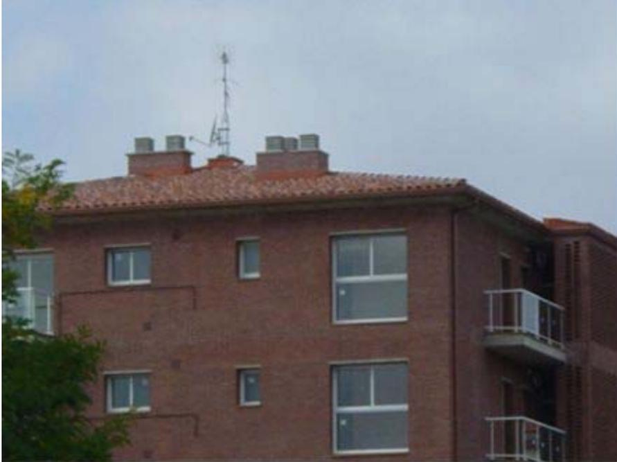
En las cubiertas inclinadas es recomendable la existencia de una plataforma para el anclaje de las torretas, pero no debe olvidarse que debe disponer de bases para la colocación de dos parabólicas.
