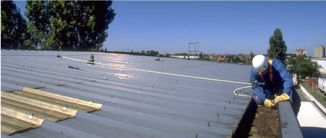
En cuanto a los soportes de las líneas de vida dependerán de si la cubierta está dotada o no de capa de estanqueidad. En el primer caso la altura será de 150 mm y en el segundo de 100 mm. El resto de elementos de la línea de vida es similar a los utilizados en cubiertas con vertientes. La plaqueta de anclaje usa cuando la intervención tiene lugar sobre un punto preciso y cuando el acceso a la plaqueta es de total seguridad.
