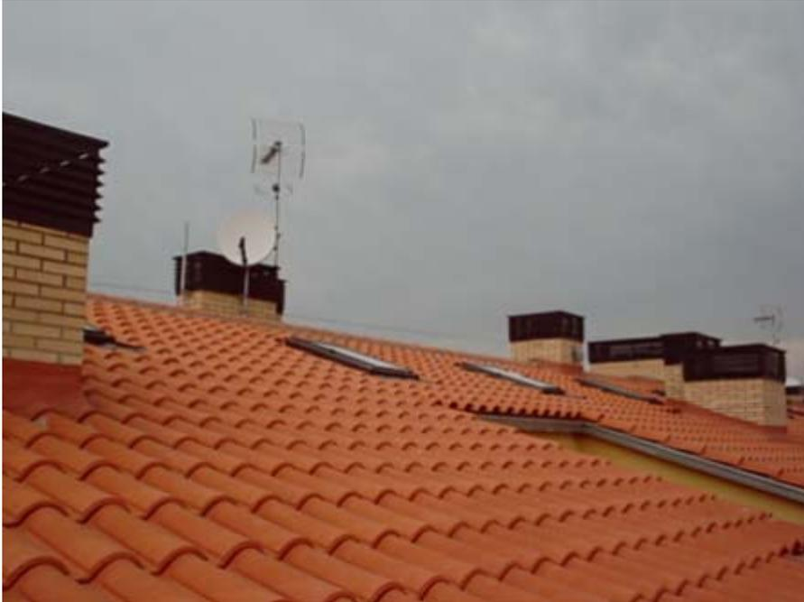
En este caso, se accede a la cubierta a través de la terraza de un ático. En la cumbre hay una línea de vida que se puede alcanzar mediante una pértiga desde el punto de acceso a la cubierta.
