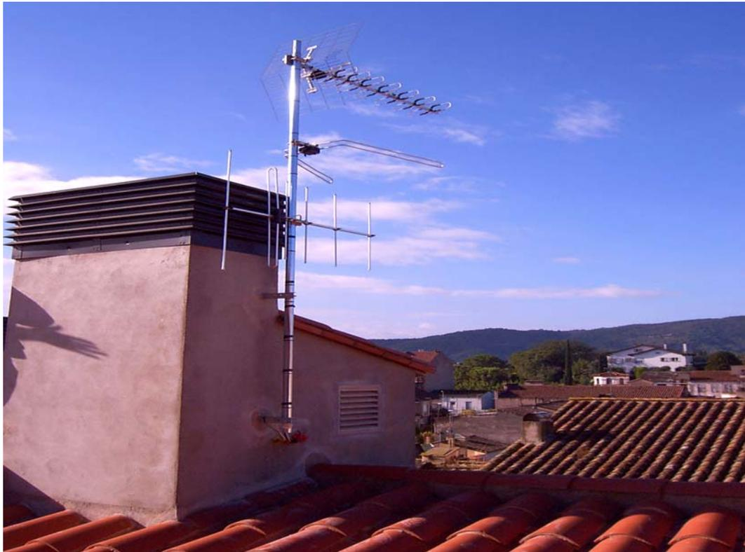
En este caso desde la salida a la cubierta hasta la zona donde se sitúan los elementos de captación no existen anclajes para que los instaladores puedan fijar mosquetones para los arneses. Como resultado las antenas están muy poco separadas y el mástil está fijado a una chimenea. Además no existen las bases para las antenas parabólicas. Foto cortesía: Jefatura de Gerona.
