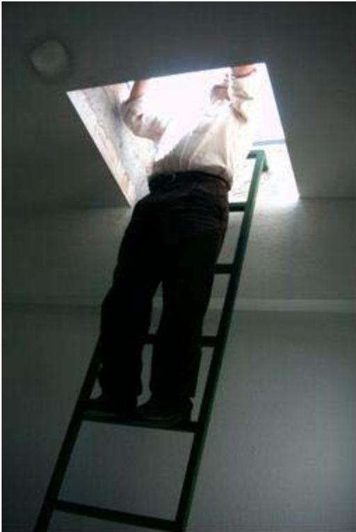
En este caso, el acceso a la cubierta mediante trampilla se realiza mediante una escalera fija en el edificio. Evita así, utilizar una escalera de mano, agilizando el acceso a cubierta y evitando riesgos.
