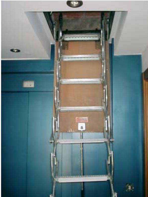
El acceso a la cubierta mediante trampilla, se realiza mediante una escalera telescópica unida a la trampilla pero disponible permanentemente en el edificio.
