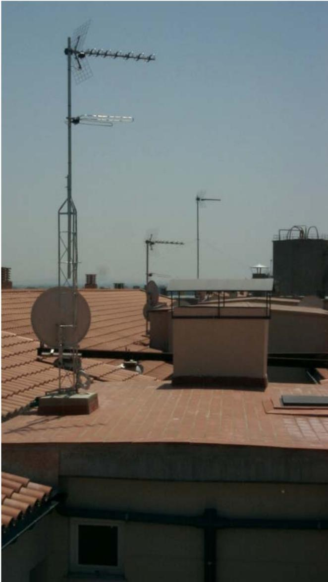
En este caso la superficie de trabajo es suficientemente amplia y dispone de un acceso. Sin embargo, debería existir una barandilla para reducir totalmente el riesgo de caída. Foto cortesía: Jefatura de Girona.
